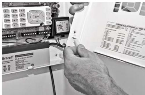
e procedete con la chiusura definitiva avvitando saldamente le quattro viti poste sul lato superiore e inferiore del contenitore.
